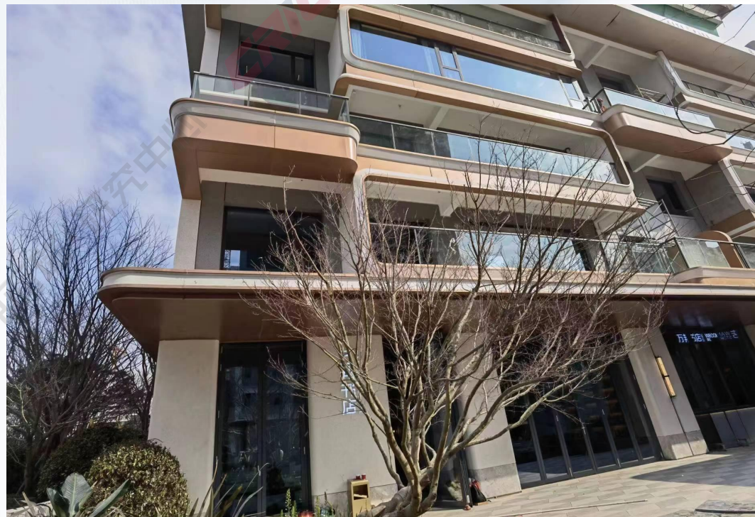
▲ 西安中国铁建西派玺外立面实拍
