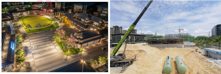
△ 海南蓝湾小镇中央公园实景及地下蓄水罐铺设过程
