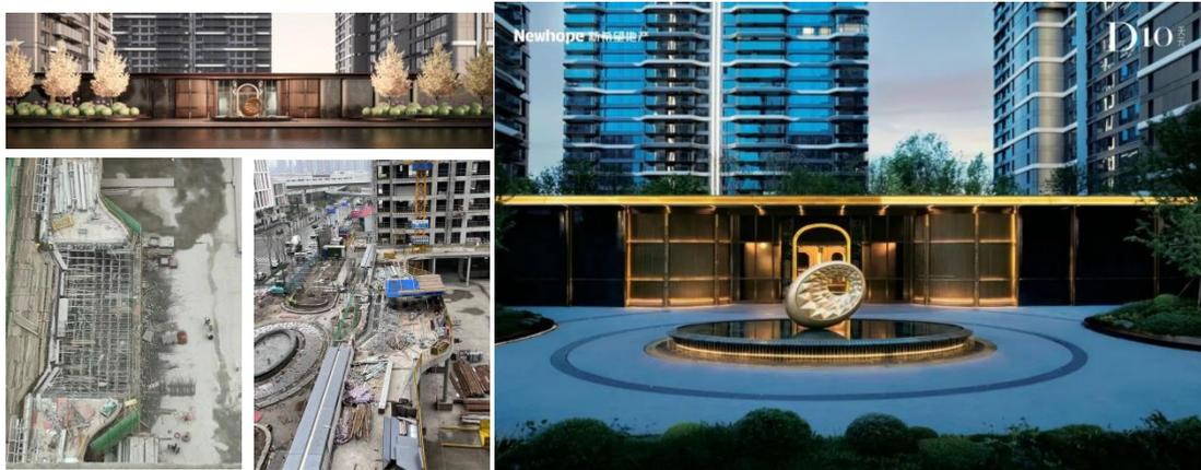
**案例 2：**原电梯核心筒背立面外墙原设计采用平板铝板。为实现更完美的效果，通过多轮现场打样及方案比选，最终选定折线线条方案，为此拆除已完工铝板并重新施工实现立面焕新。并将全楼弧形玻璃升级为低眩光双层超白玻，提升视觉效果。
