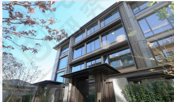
▲ 杭州绿城咏溪云庐北立面实景
