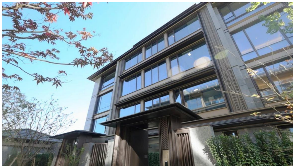
图：杭州绿城咏溪云庐北立面实景
